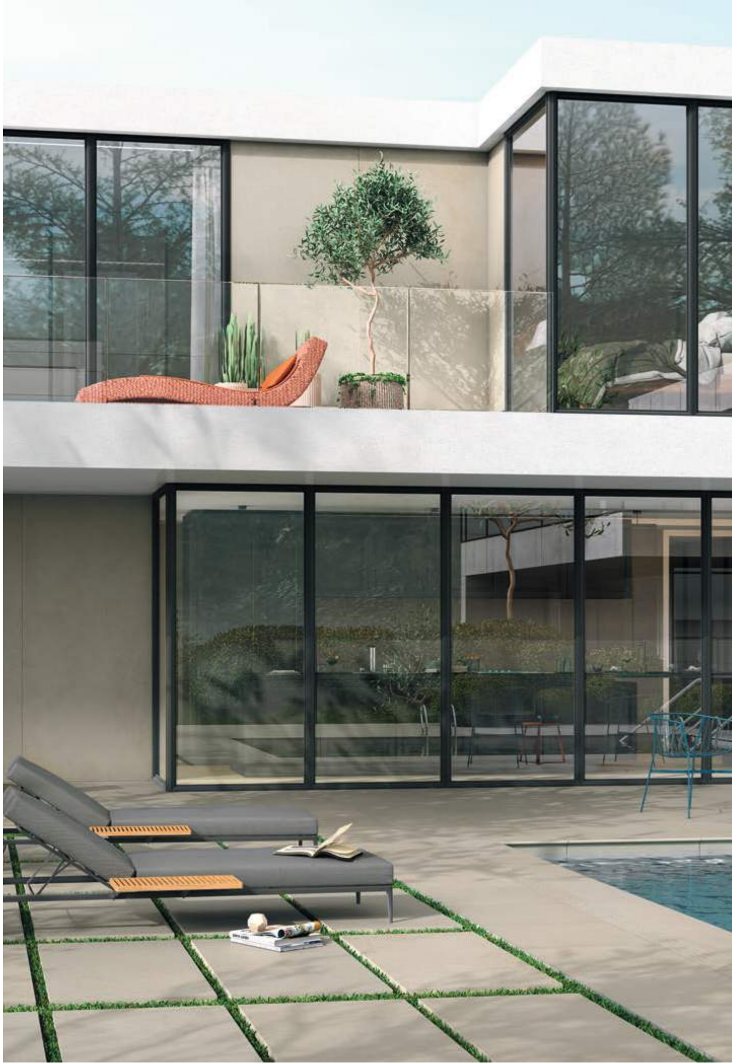
PAVIMENTO / FLOOR Square Strutturato 60x60 cm Rect - 24"x24" _Square Strutturato 60x120 cm Rect - 24"x48" 20 mm
